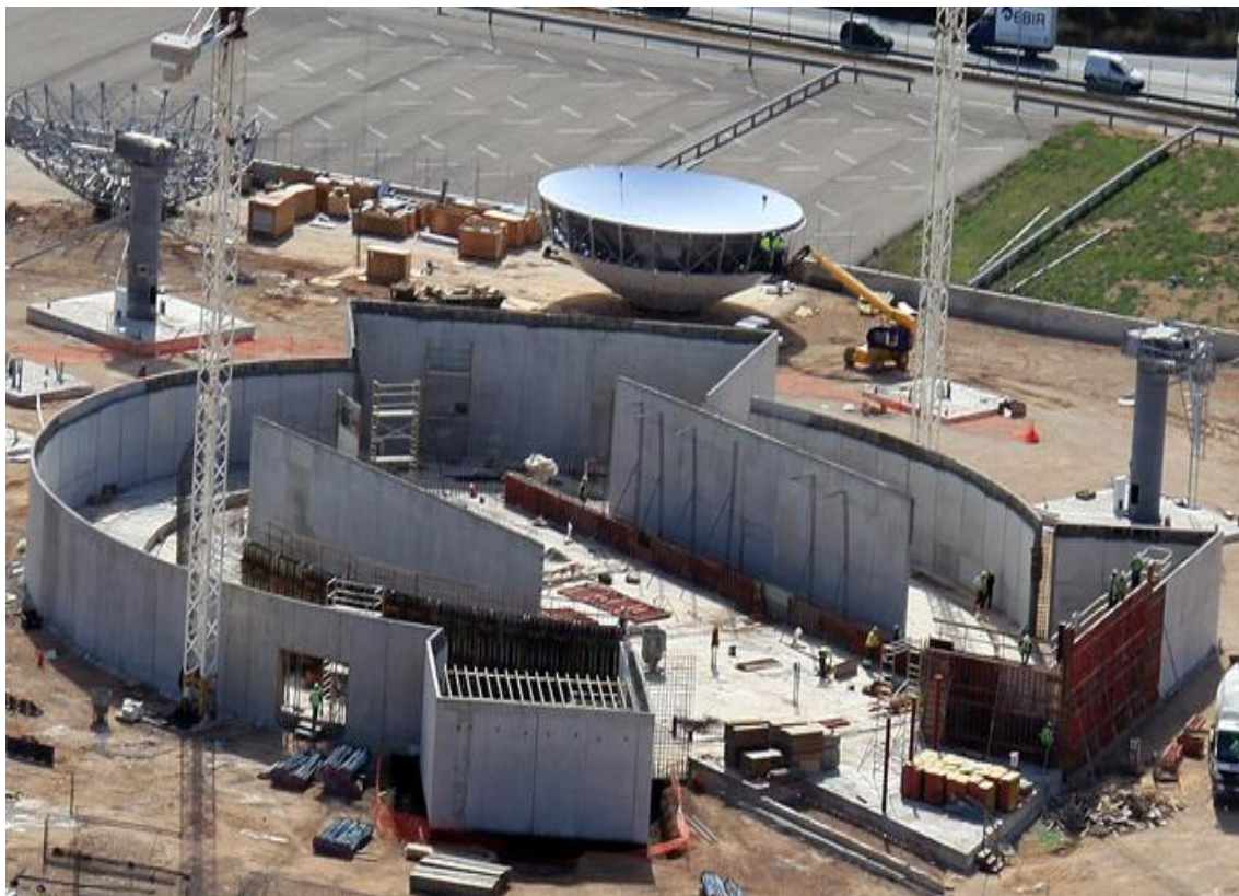
Fase de construcción de la estructura del Data Centre
