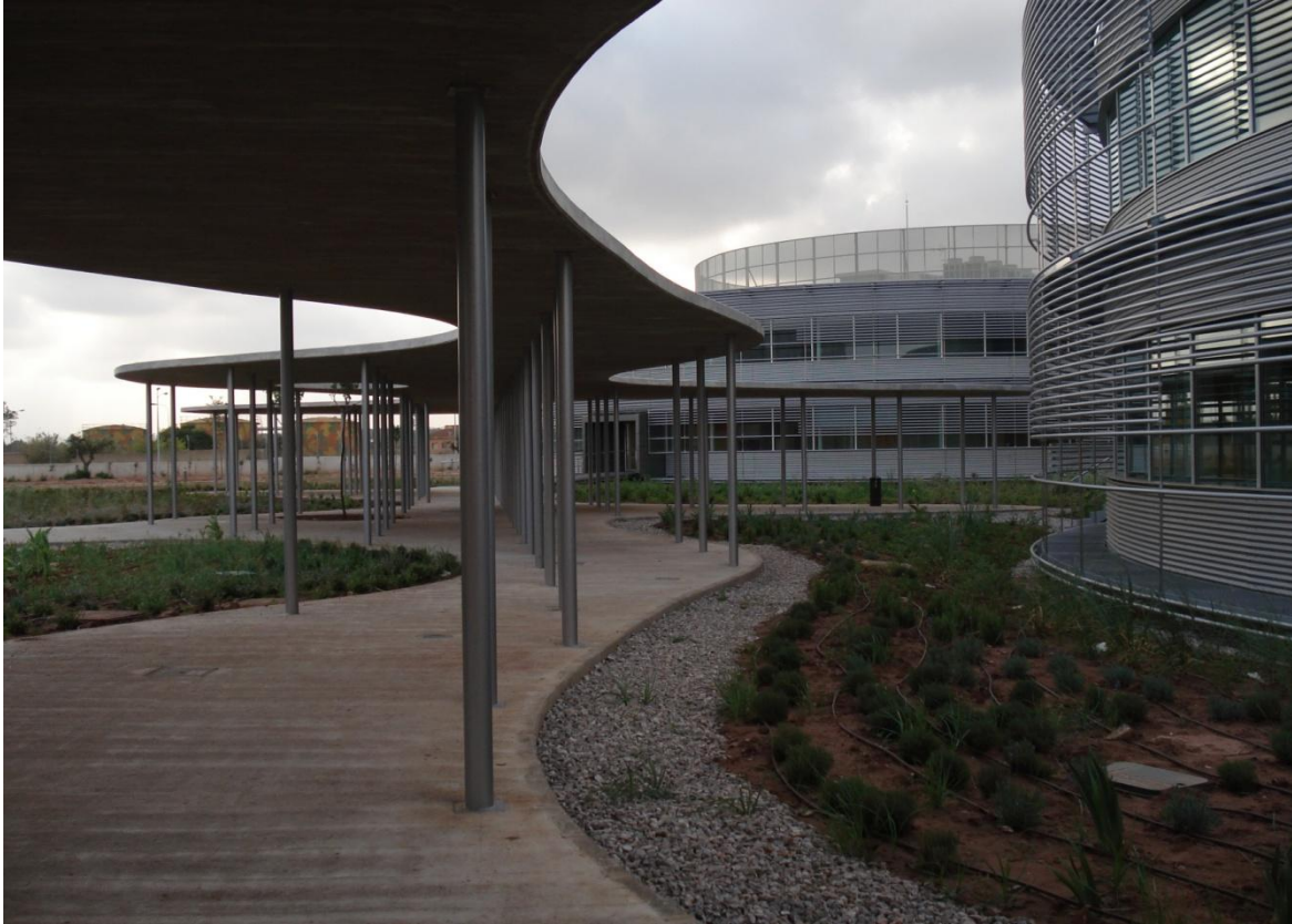
Vista de pérgola de unión entre edificios
