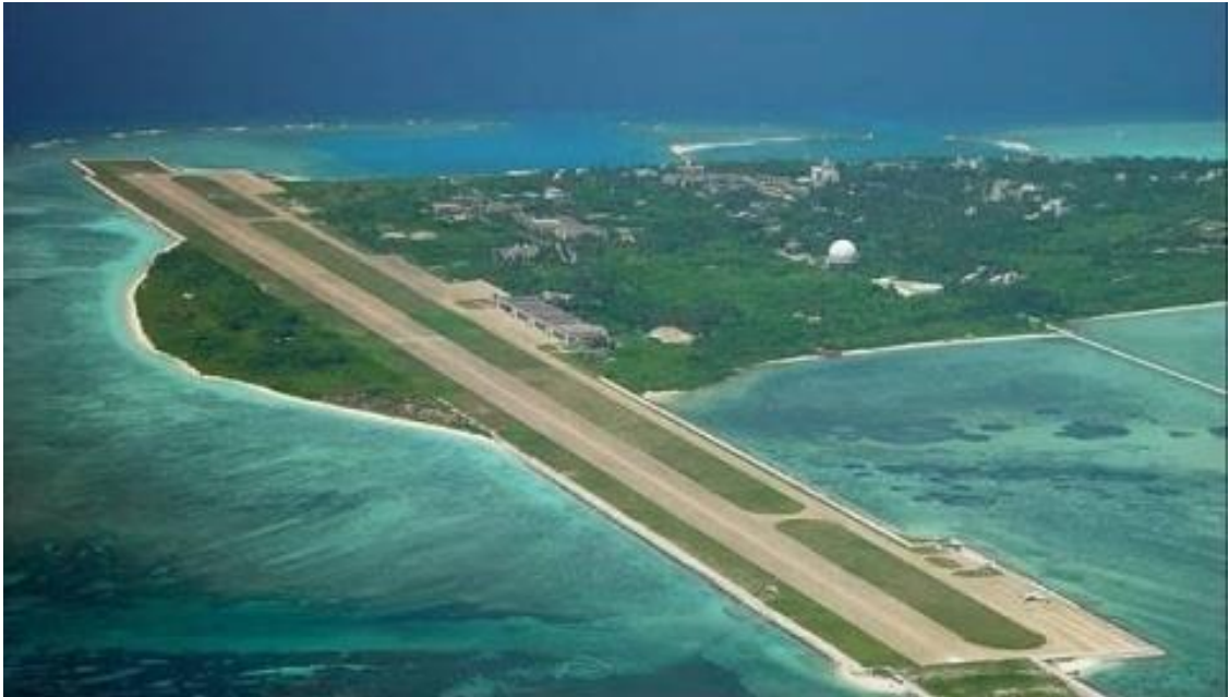
Imagen 5: Construcción de un campo de aviación en Fiery Cross Reef. (fuente: Getty Images)
