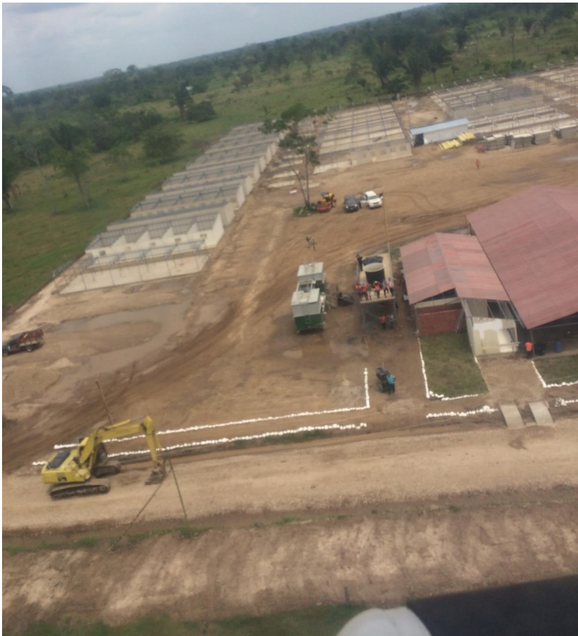
Figura 6: Vista de las obras de un campamento FARC en Filipinas (Arauca).
