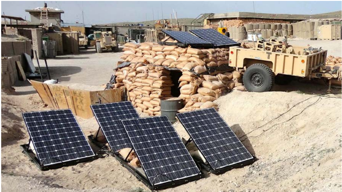
Figura 1: Paneles solares “rugerizados” en FOB Ghazni (Afganistán). Fuente: US Army.
