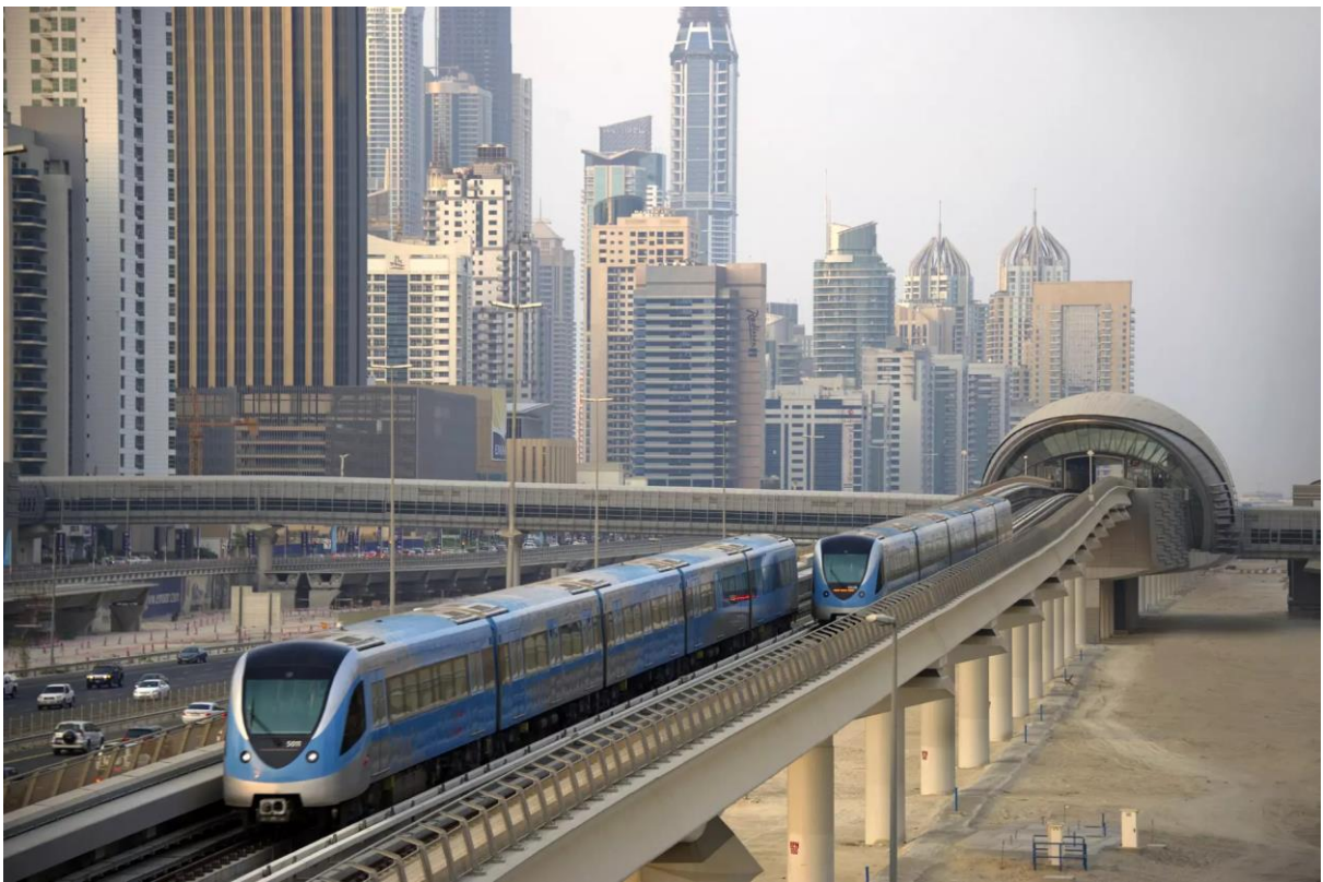
Figure 3. Infrastructure ferroviaire à Dubaï. Source. Nikkei Asian Review.
